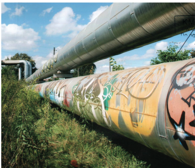
Ryc. 1. Rury ciepłownicze, przy których znaleziono zwłoki.
