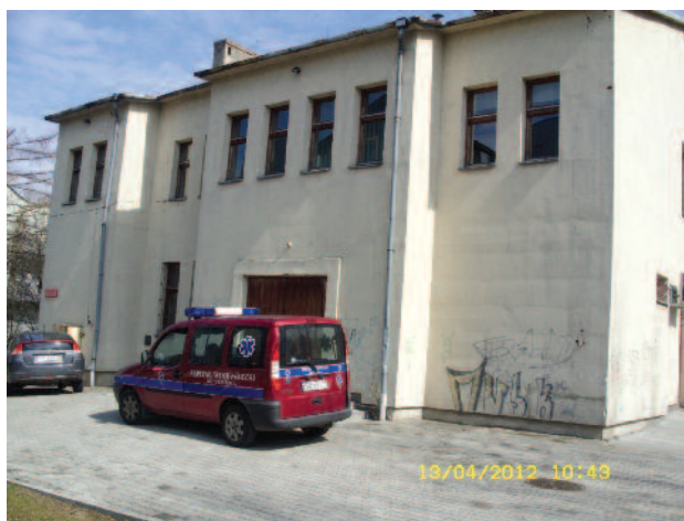
Ryc. 1. Budynek Zakładu Medycyny Sądowej w Bielsku-Białej.
